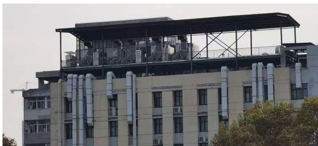
化学楼实验室通风系统改造工程
